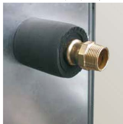
Проход сквозь обшивку с изоляцией Armaflex
