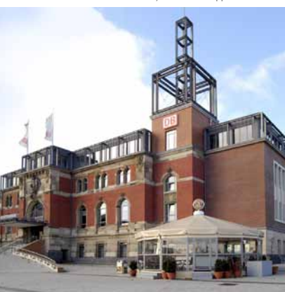
Центральный вокзал в Киле
